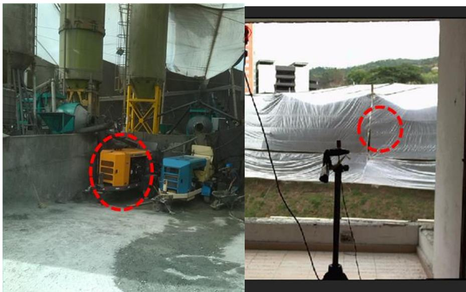
**Fig. 20. Fotografías de los puntos de medición en la obra de construcción. (Izq) Bombas de cemento, principales fuentes de ruido de la obra. (Der) Vista de la planta de mezcla de cemento desde un apartamento cercano.**
